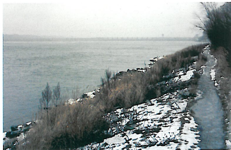
Wał przeciwpowodziowy, w oddali widać zapórę wodną
