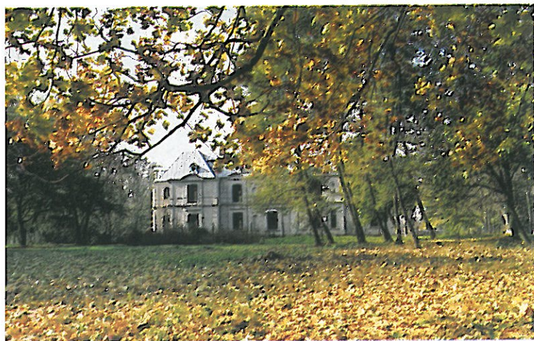
Pałac w Więślawicach od strony zachodniej
