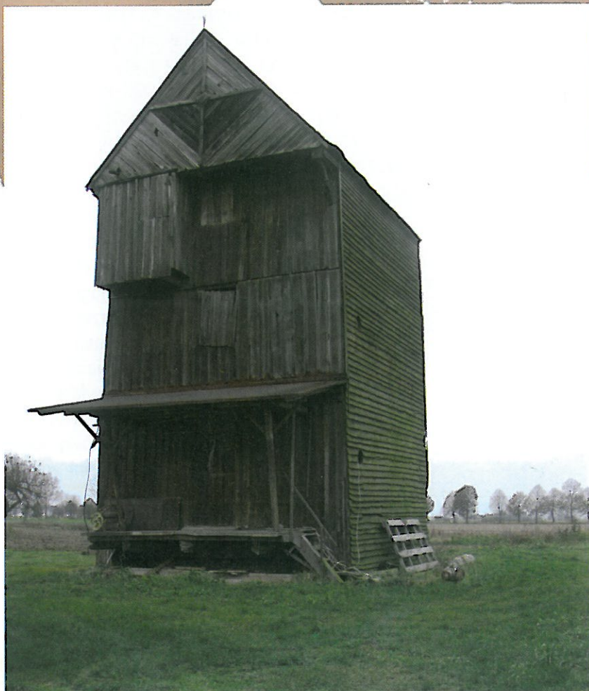
Wiatrak paltrak, Pomiany, fot. J. Sierackiewicz
