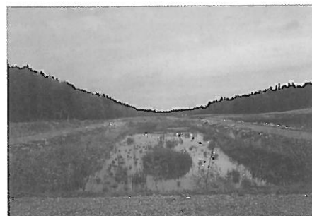
Oczyszczalnia związków biogenych (azotu, fosforu) - zbiornik retencyjny. Fot. Ewa Gajewska.
