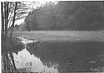
Oczyszczalnia hydrobotaniczna. Fot. Ewa Gajewska.
