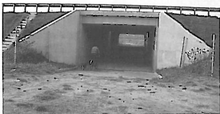
„Nowatorskie”, uniwersalne przejścia dla zwierząt, ludzi i pojazdów na toruńskim odcinku autostrady A-1. Fot. F. Barche.
