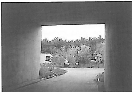
Przejście dla dzikich zwierząt leśnych na toruńskim odcinku autostrady A-1, ciekawe jakich?. Fot. F. Barche.
