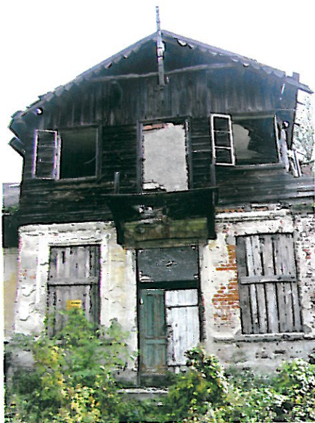
Ganek i balkon od strony frontowej
