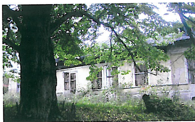
Widok na pomnikową lipę i elewację wschodnią dworu
