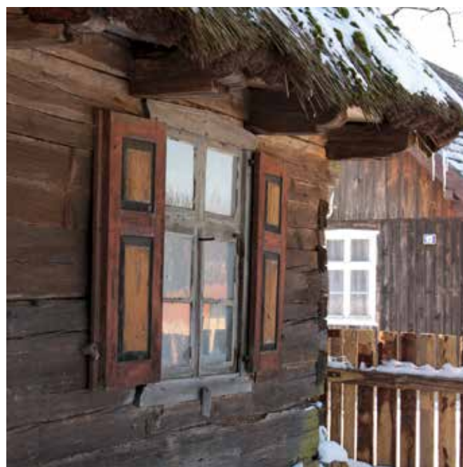
Drewniana zabudowa w m. Krąg fot. R. Borzyszkowski
