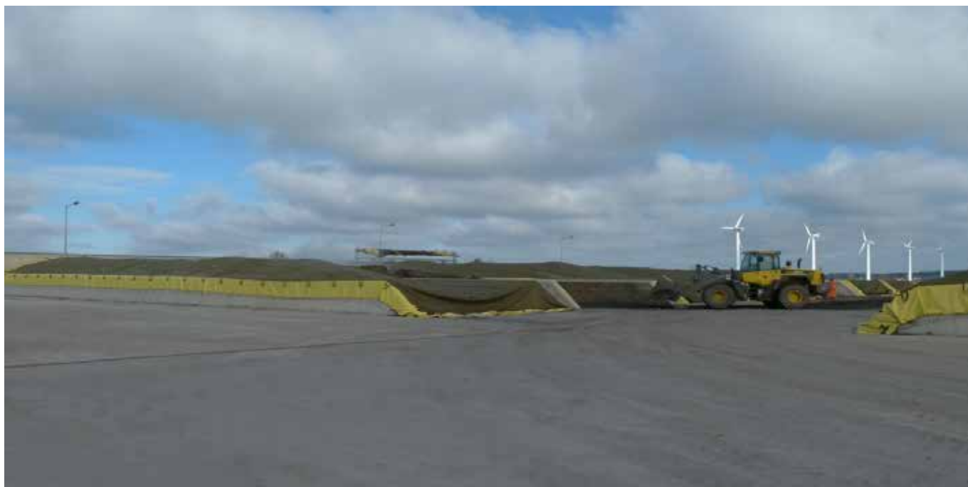
Rys. Rozładunek odpadów z boksów po zakończeniu procesu
