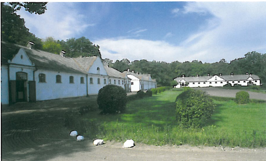
26. Łąck – obiekty stajni
